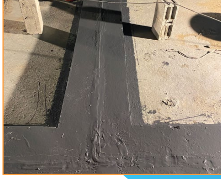
دهان فواصل التمدد بمادة البولوريا الباردة Painting the expansion joints with cold polyurea
