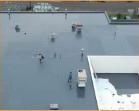
عزل الأسقف بمادة البولوريا الباردة Waterproofing ceilings with cold polyurea
