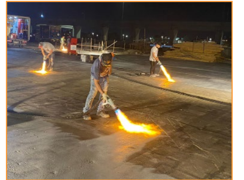
عزل بمادة البولي إيثلين Polyethylene waterproofing
