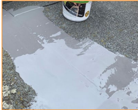
عزل بمادة البولوريا الباردة Waterproofing with cold polyurea material
