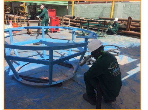
عزل الخلاطات الصناعية بمادة البولي ايثلين Waterproofing of industrial mixers
