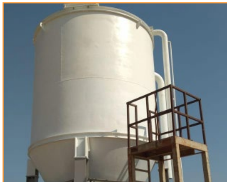
عزل الأسطح المعدنية بمادة البولي إيثلين Waterproofing steel structure
